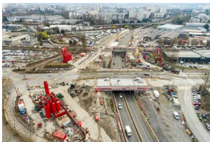
Vue du chantier au Rondeau.
